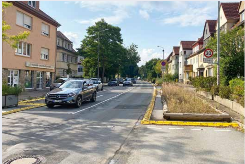
Ein ehemals vierstreifiger Wohngebietszubringer wird auf zwei Fahrstreifen zurückgebaut. Die jeweils äußeren Fahrstreifen werden umgenutzt.
